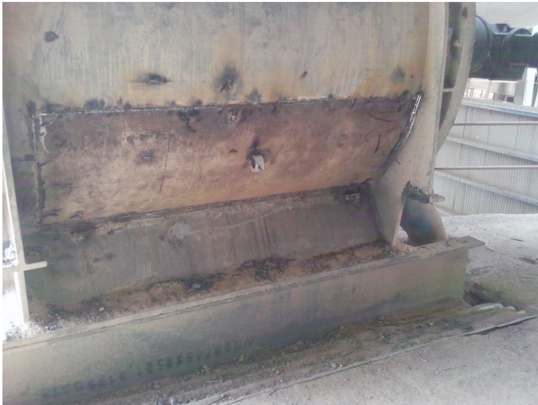
تصویر ۴- روتاری قبل از اجرای طرح (قسمت آسیب دیده توسط ورق جدید اصلاح شده است).
